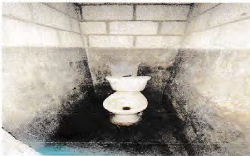
Foto 3: sustitución de inodoros con todos sus accesorios y con drenado de agua
