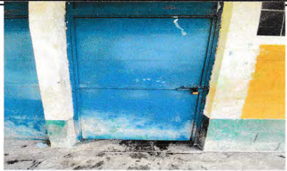
Foto 2: sustitución de pintura y reparación de la mitad de lámina de la puerta y cambio de chapa la puerta mide de largo 2mts con 7 centímetros
