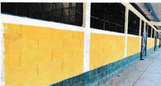
Foto 5: pintura para los salones de clases por dentro y por fuera
