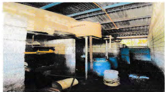
Foto 6: sustitución de tubería para abastecerse de agua en cocina y en sanitarios
